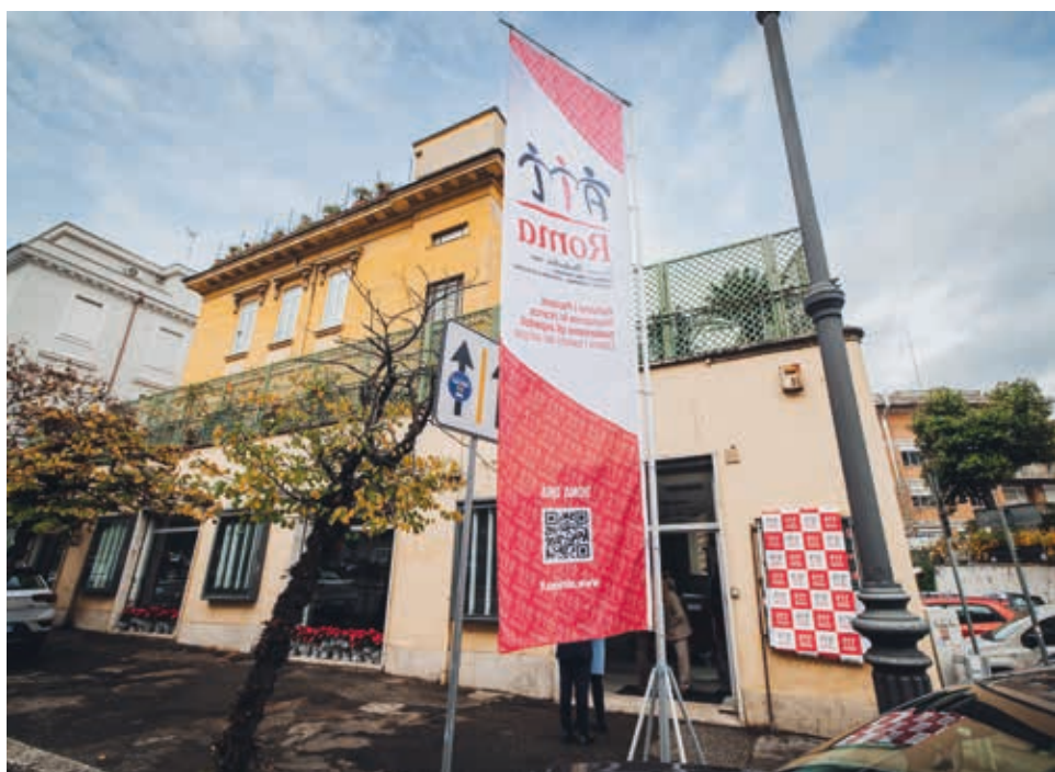
L'esterno del Centro Mandelli all'angolo tra via Bari e via Benevento.
